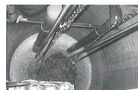
2 - POMPES DE RELEVEMENT Placées dans une fosse de réception, 2 pompes relèvent les EU vers le réservoir surélevé (B).
