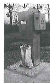
1 - DEGRILLEUR Appareil consistant à prélever les plus gros débris. Ex : serpilles, balles de tennis et bien d'autres choses.
